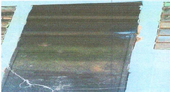
FOTO 3: SUSTITUCIÓN DE PUERTA
