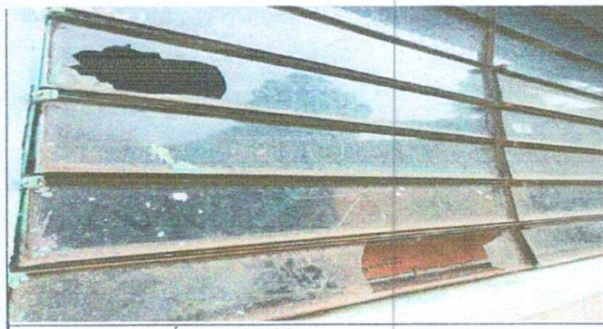
FOTO 5: SUSTITUCIÓN DE VIDRIOS
