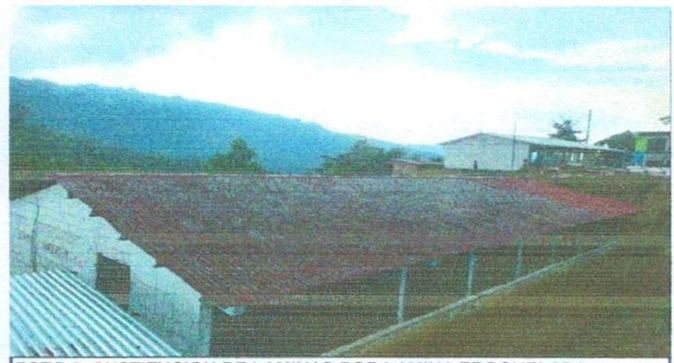
FOTO 6: SUSTITUCIÓN DE LAMINAS POR LAMINA TROQUELADA
